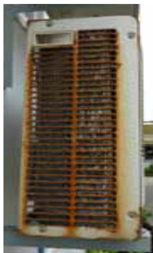
Gambar 17 Kondisi AC yang tidak layak diretrofit HC [3].
