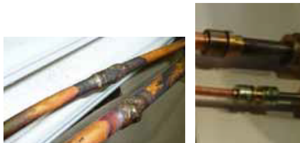
Gambar 19 Sambungan pipa dengan brazing (a), sambungan lokring (b) [3].
